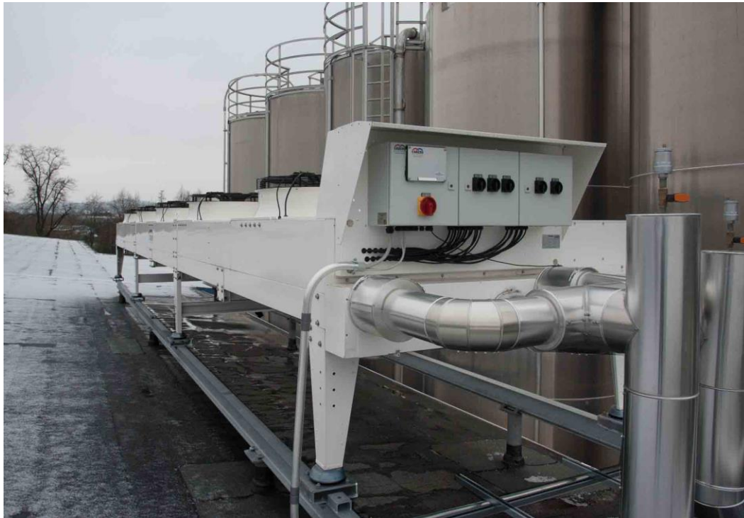
Der neue Freikühler hat auf dem Hallendach Platz gefunden.
