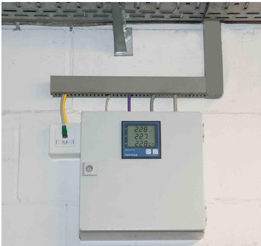
Das kompakte UMG 96RM-E erfasst die Messdaten eines Verbrauchers und dient als Gateway für die Visualisierung aller Verbraucher.
