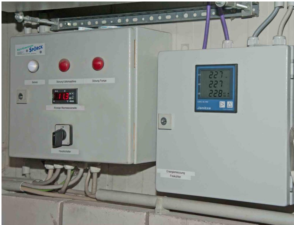
Über UMG 96RM-CBM Module werden die Messdaten erfasst und über den Modbus an die Visualisierung weitergegeben.
